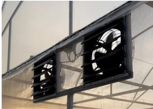
ภาพที่ 6 พัดลมระบายอากาศที่ติดตั้งบริเวณท้ายโรงเรือน
